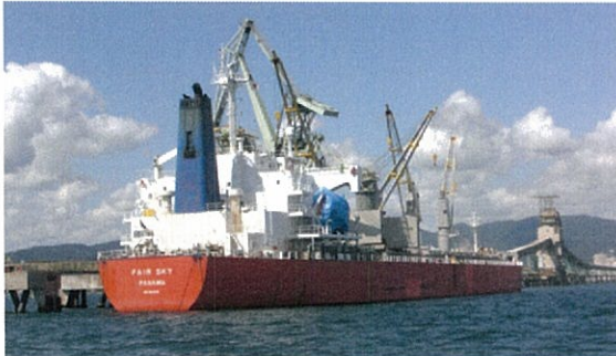
【セメント工場から海上に伸びる栈橋】
